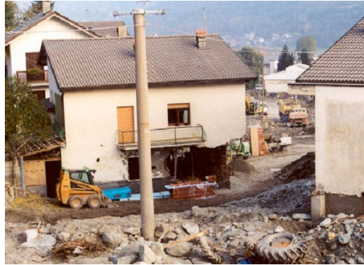
Photo 6.8 : Val d'Aoste 2000, endommagement d'un angle
