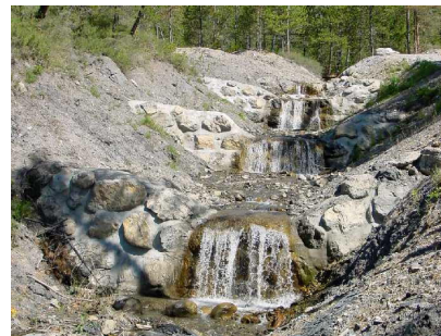
Photo 2.16 : Barrages en enrochements - Embrun
