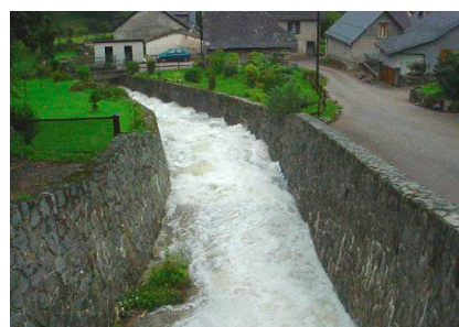
Photo 2.26 : Canalisation d'un torrent - Bielle
