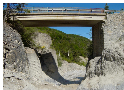
Photo 2.23 : Détecteur de lave torrentielle
