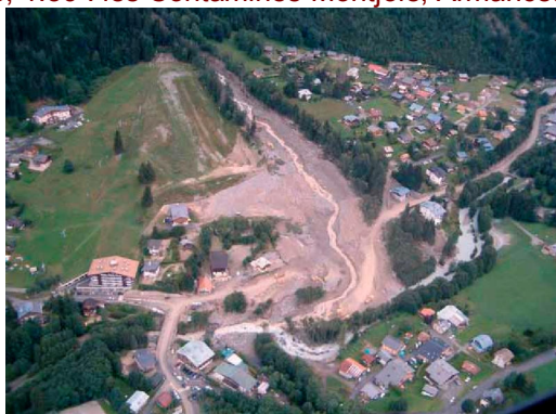
Source : Mairie des Contamines-Montjoie
