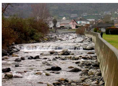
Photo 2.24 : Endiguement d'une rivière torrentielle - Soulom
