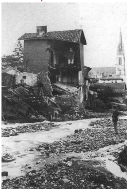
Photos 4.7, 4.8, 4.9 : Vulnérabilité des angles des bâtiments en maçonnerie Voiron, 1897
