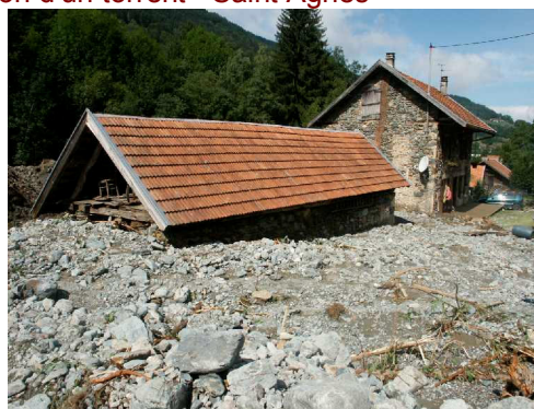
Photo 2.2 : Dépôts de charriage faisant suite au débordement et à la divagation d'un torrent - Saint Agnès
