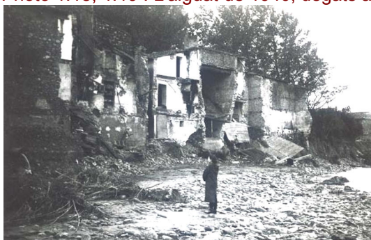
Photo 1.18, 1.19 : L'aiguat de 1940, dégâts à Nefiach
