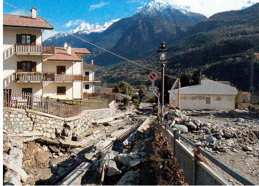
Photo 6.9 : Val d'Aoste 2000, destruction des réseaux
