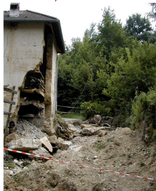
Photos 4.7, 4.8, 4.9 : Vulnérabilité des angles des bâtiments en maçonnerie Voiron, 1897
