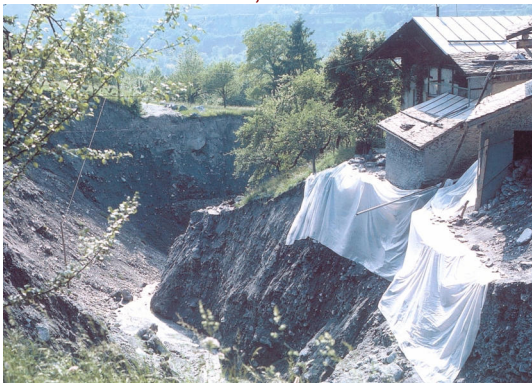
Photos 4.5, 4.6 : Affouillements Torrent de la Ravoire, 1981
