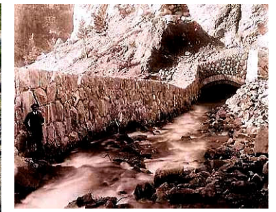
Photo 2.17 : Tunnel de dérivation - Guillestre
