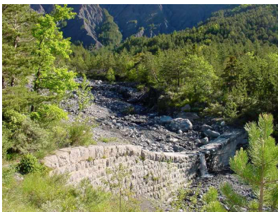
Photo 2.15 : Barrage en maçonnerie – Villeneuve d'Entraunes
