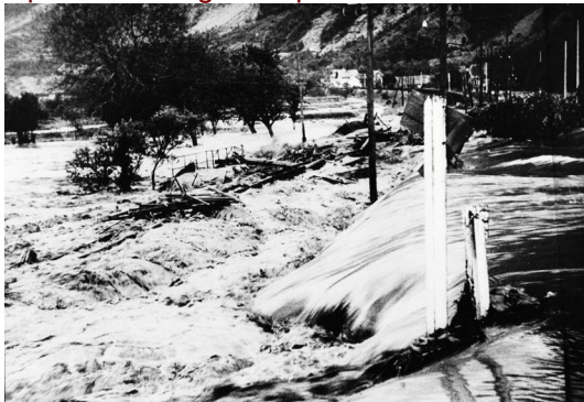
Photos 1.20, 1.21 : 1957, crue de l'Arc rupture de la digue de protection des Reisses
