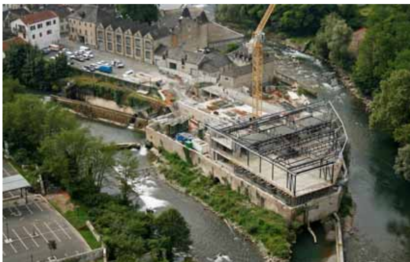
▶ Juillet / Septembre 2008 Montage de la structure métallique
