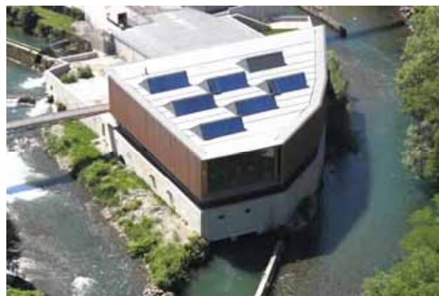
▶ Octobre / Décembre 2008 Couverture zinc sur volige
