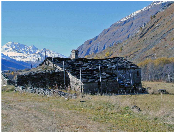
Figure 1.5 Étrave maçonnée devant une habitation à Bessans.
