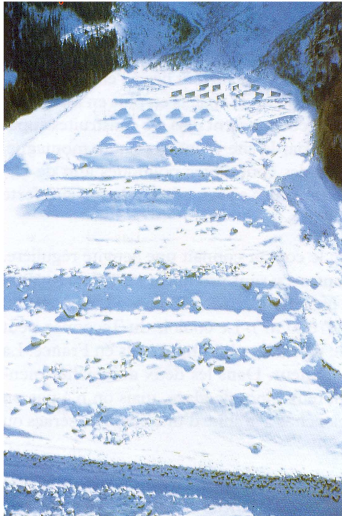
Figure 8.3 Vue aérienne du dispositif de Tacconnaz en février 1992. Le coût a été de l'ordre de 5 millions d'euros. Cliché C. Charlier.
