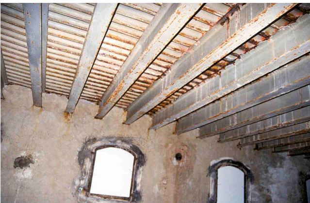
Détail poutraison métallique sous terrasse
