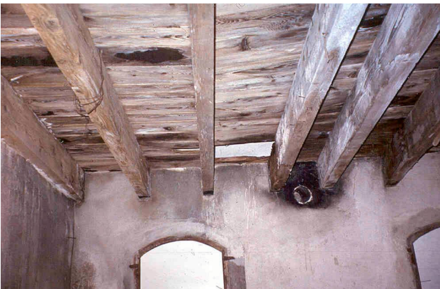
Détail plancher et escalier en bois
