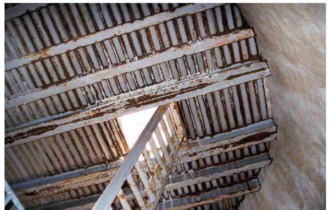
Détail poutraison métallique sous terrasse
